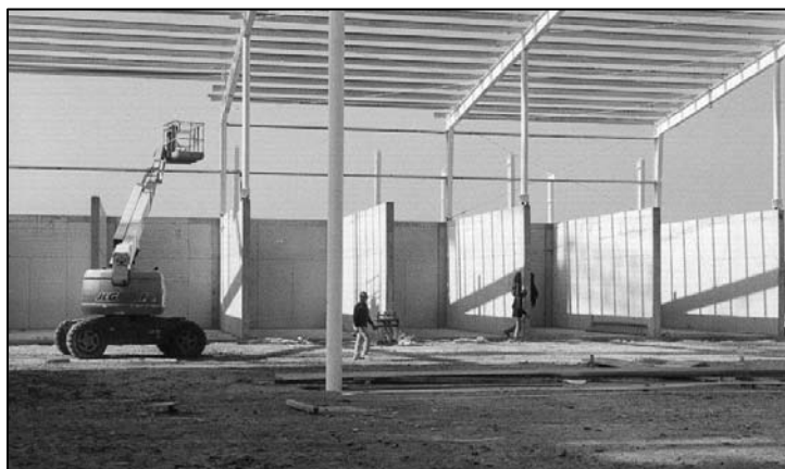
Foto 15 – Obra Planta Industrial.
