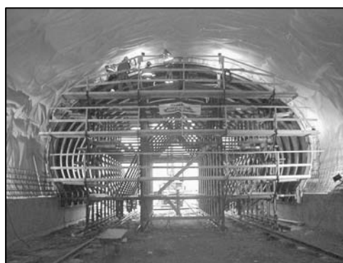
Foto 11. HAC en túneles con acceso interior.
