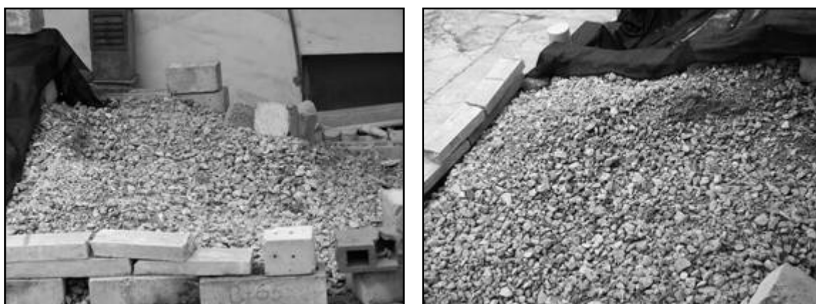
Figura 4.3 – Acopio de agregados reciclados de la Serie A.
